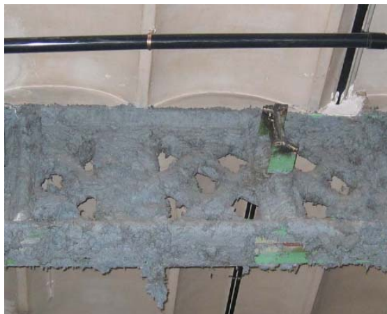
Figura 4. Flocage ignifugante de viga metálica
