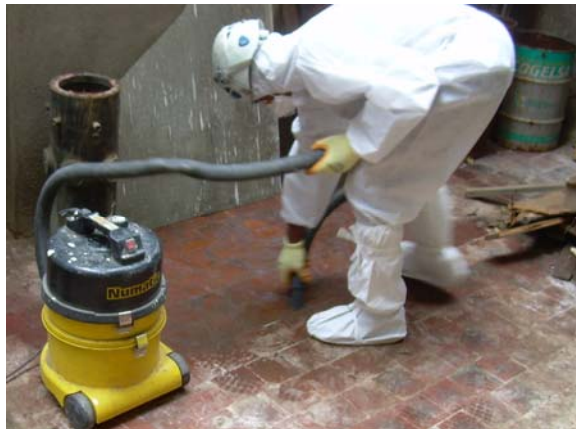
Figura 11. Aspiración de las zonas de trabajo
