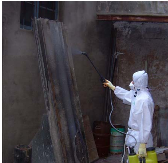
Figura 10. Aplicación de productos encapsulantes
