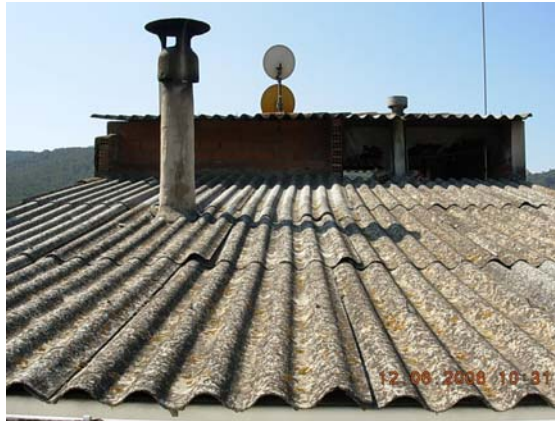
Figura 3. Cubierta y chimeneas de fibrocemento
