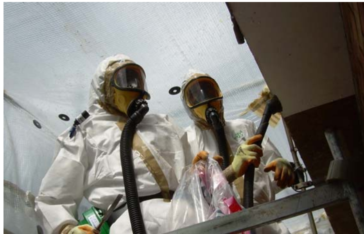
Figura 19. Equipos de protección individual (Desamiantado friable)
