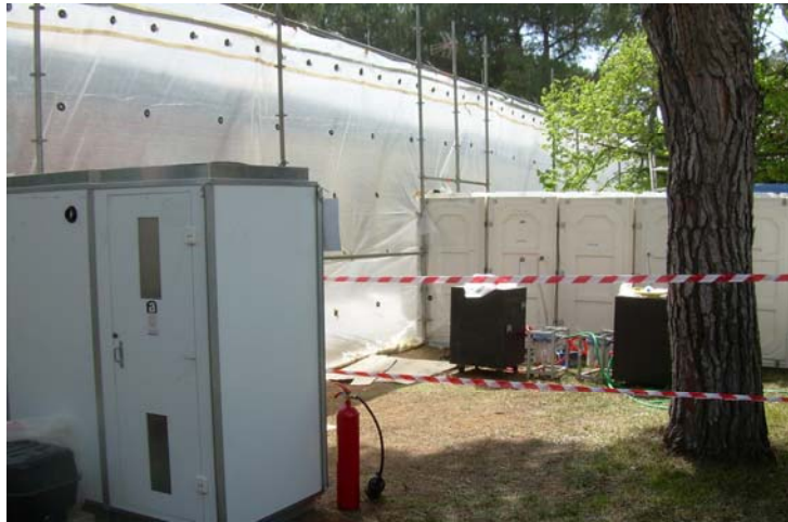
Figura 18. Túneles de descontaminación de residuos (2 compartimentos), y de los trabajadores (5 compartimentos)
